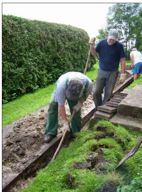
Abbildung 2: Die Kabelgräben werden ausgehoben
