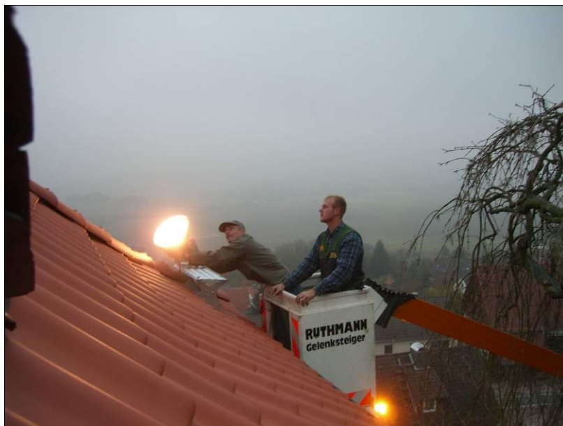
Abbildung 3 und 4: Mittels eines Krans werden die Dachstrahler installiert
